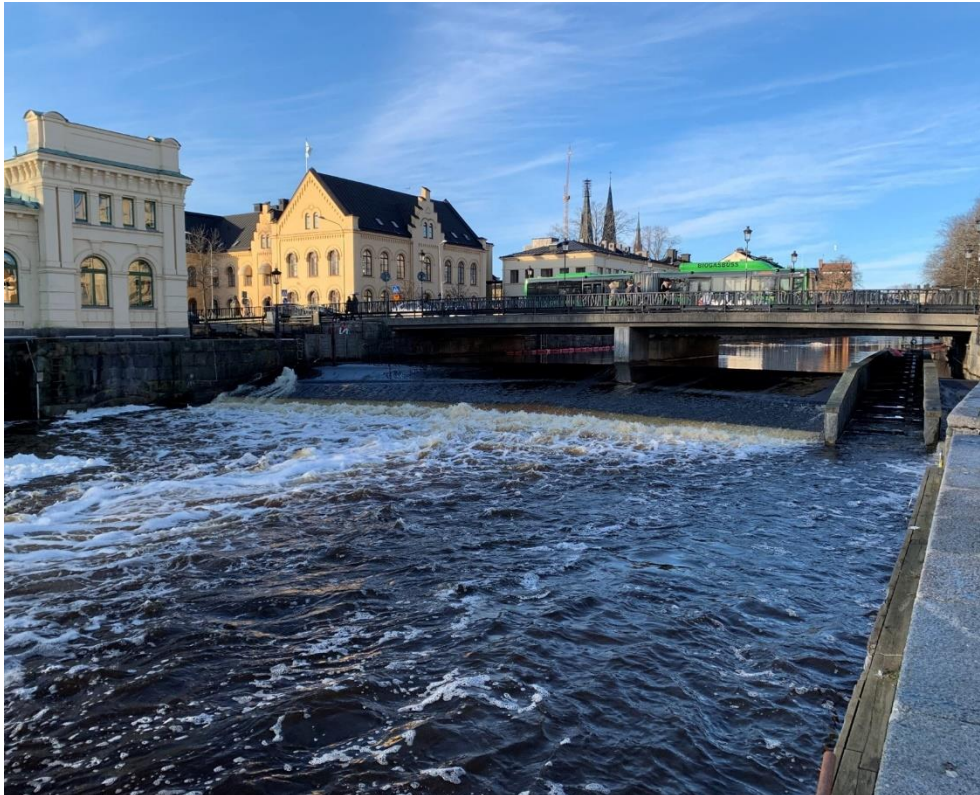
Figur 1. Fyrisån vid Islandsfallet sett från nedströmssidan.
